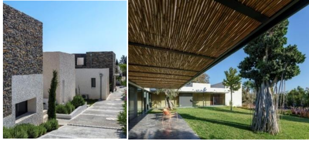
Şekil 9: T Evi Malzeme Görünümü (URL-11).
